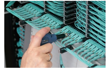
写真 24.1.3 使用例：パッチパネル側の 端面検査
