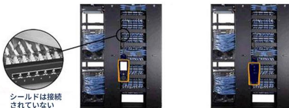
図 2 - 別の規格適合リンクを介したスクリーンの導通経路
