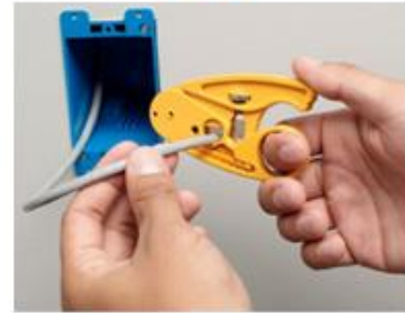
写真 4-1 正しい工具を使った外皮の除去
